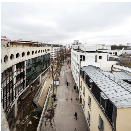
Repose de la structure. © Patrick Tourneboeuf / Février 2024
