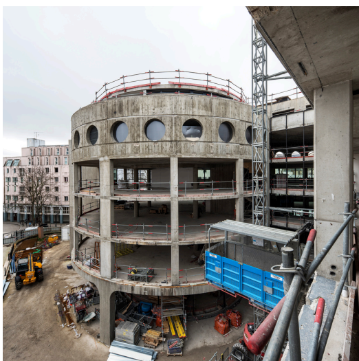
Dépose des verres et de la structure. © Patrick Tourneboeuf / Février 2024
